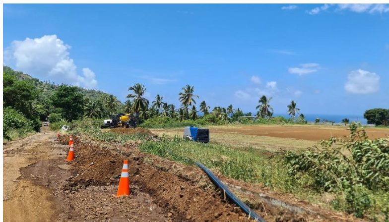
Photo 5. Adduction d'eau en cours (village Chezani)
