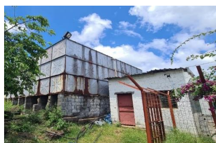
Réservoir d'eau (village Hadawa)
