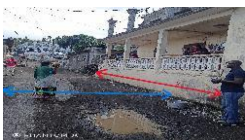
Exemple de minimisation en évitant d'impacter la façade d'un bâtiment à Mahoro (distance minimale 1mètre de la route).
