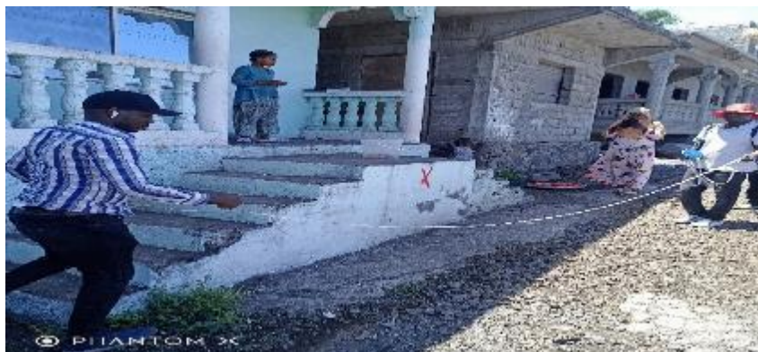
Photos 2 : Escalier impactés
