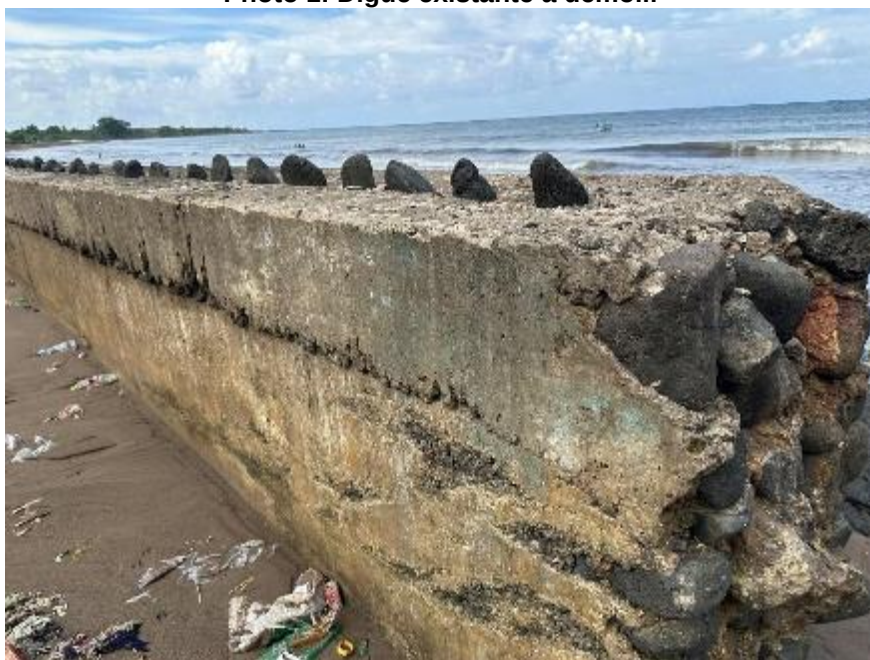
Photo 1: Digue existante à démolir
