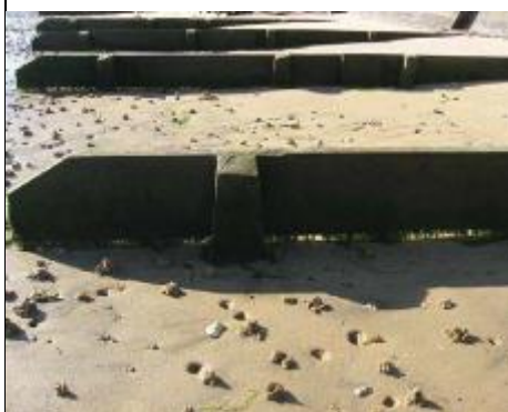
Photo 14: Exemple d'un épi bois vertical
