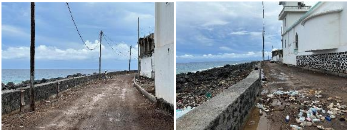
Photo 22: Mur en construction sur l'emprise du mur de protection incurvé prévu sur le site de Foubouni
