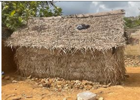
Photo 20 : Vue de l'unique structure à usage d'habitation temporaire (non exploitée) impactée au niveau de l'emprise des travaux à Nioumachoi
