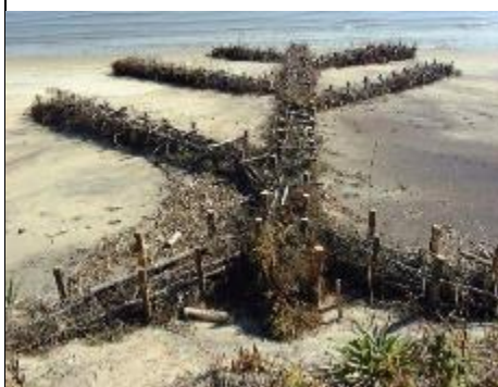
Photo 14: Exemple d'un épi bois vertical
