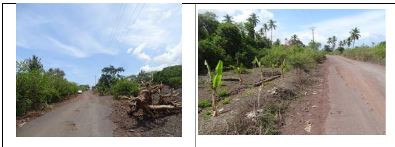
Photo 36 : illustration de l'état actuel de la route
